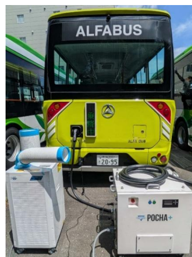
EV バス（L6）から急速充電器 Pocha+ を経由しスポットクーラーへ給電中の様子
