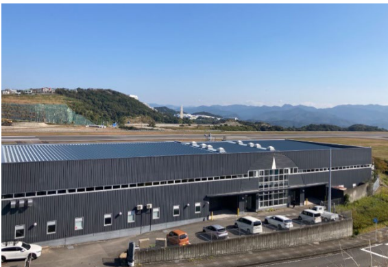
&lt;加賀エアロシステム本社外観（南紀白浜空港近接）&gt;
