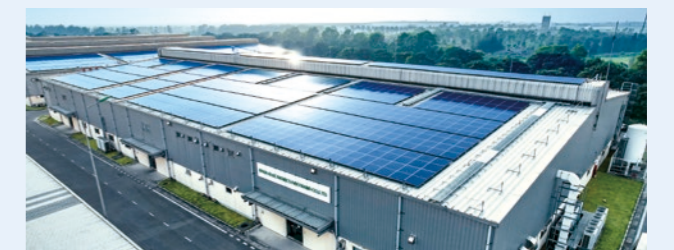
ベトナム工場に設置した太陽光パネル
