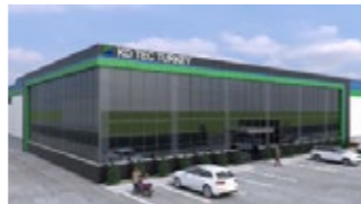
2022年11月に竣工予定のトルコの新工場
