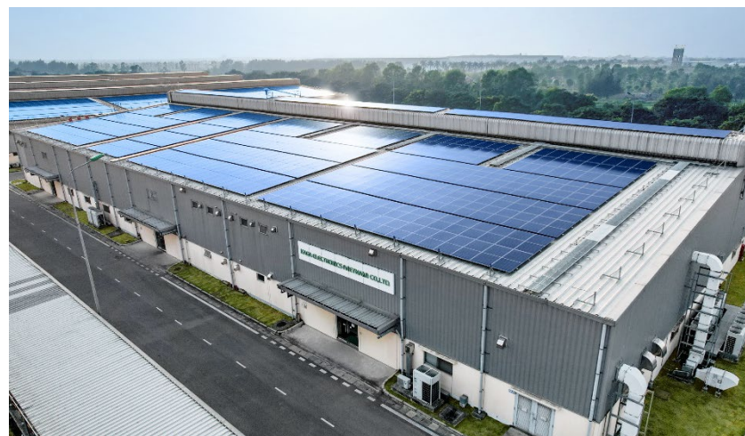
＜ベトナム工場設置の太陽光パネル＞
