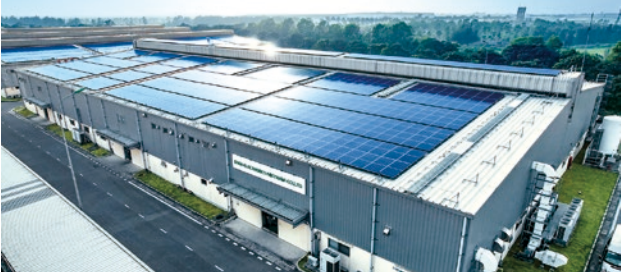
ベトナム工場に設置した太陽光パネル
