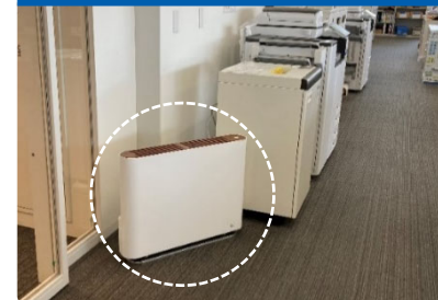
光触媒除菌脱臭機を設置
